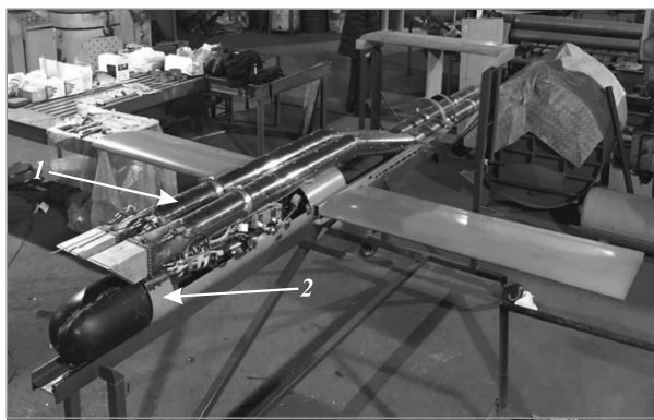
Рис. 7 Монтаж БПЛА с СУ на основе двух ИДД: 1 — ИДД; 2 — БПЛА
